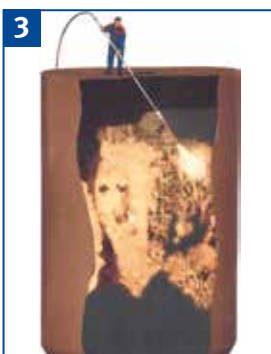
Fließstörungen im Silo nach Möglichkeit von außerhalb beseitigen, nur im Notfall einfahren.
