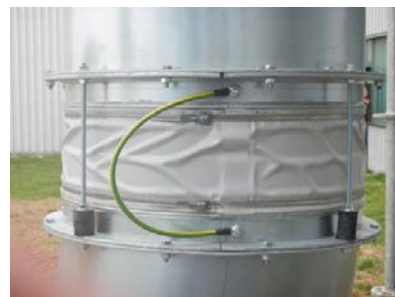
Abb. 31 Kompensator in einer Absauganlage
