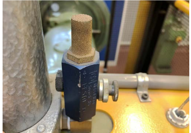
Abb. 26 Sintermetall-Schalldämpfer an pneumatischer Steuerung
