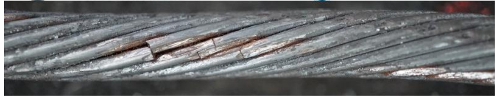
Bild 9: Drahtbrüche auf der Litzenunterseite (Außenlitze)
