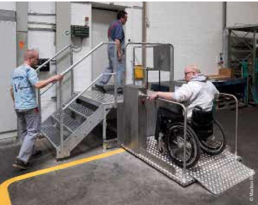
Die BGHM hat eine Bühne installieren lassen, über die Böttcher von der Montagehalle an seinen Arbeitsplatz gelangt.
