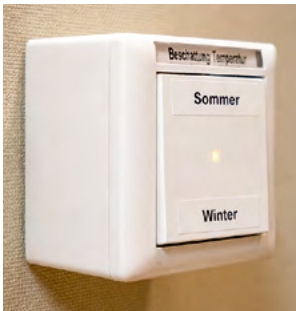
Oben: Die Zimmer können vollständig verschattet werden. Links: ein Schalter für die Beschattung der Dachfenster.
