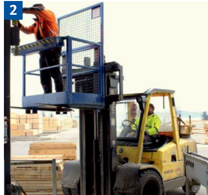
Instandhaltungsarbeiten mit Gabelstapler und Arbeitsbühne.
