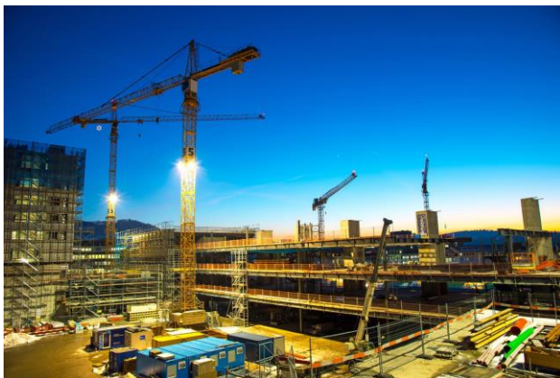
Bild 1: Turmdrehkrane auf einer Baustelle am Abend
