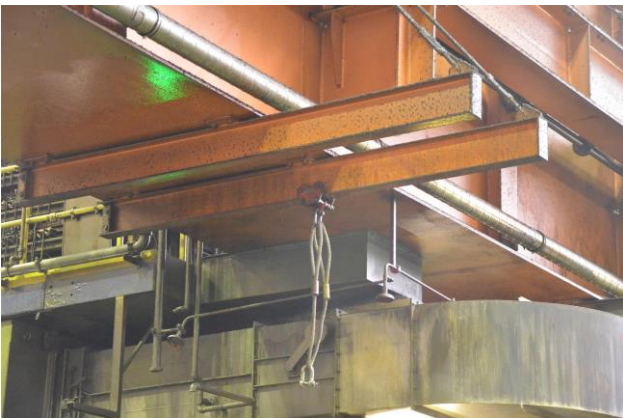
Bild 6: Ausbauträger mit Kragarm
