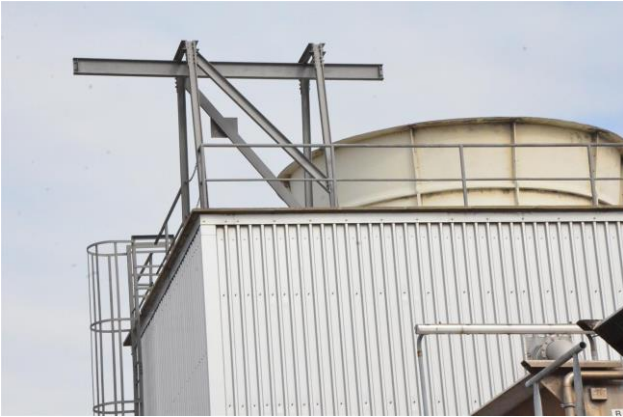
Bild 2: Ausbauträger auf Hallendach
