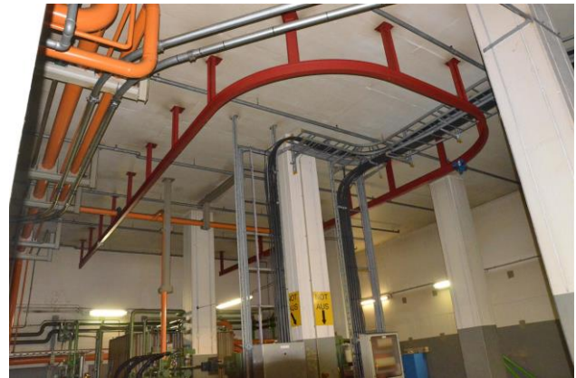
Bild 5: Ausbauträger als Kurvenbahn
