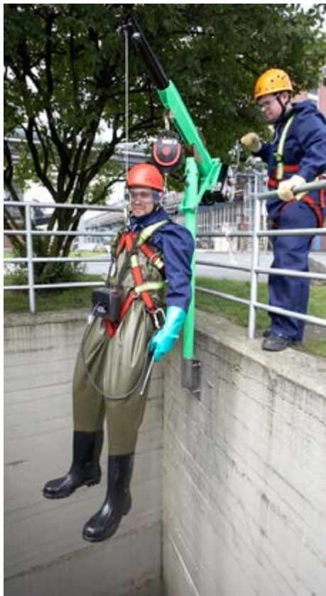
Abb. 25 Zugangsverfahren mittels Auffanggurt und Rettungswinde
