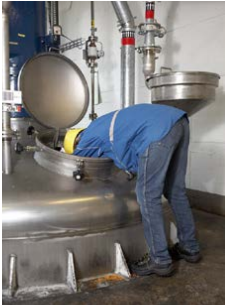
Abb. 3 Kontrolltätigkeiten (Hineinbeugen): nur mit zusätzlichen Schutzmaßnahmen möglich, hier: ein Schutzgitter im Mannloch, welches ein Hineinstürzen verhindert.
