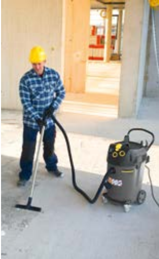
Abb. 1 Baustellenreinigung mit Staubsauger
