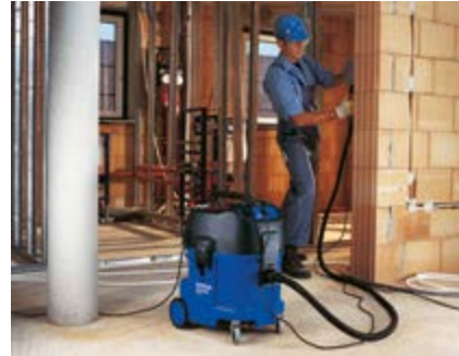
Abb. 4 Entstauber im Baustelleneinsatz
