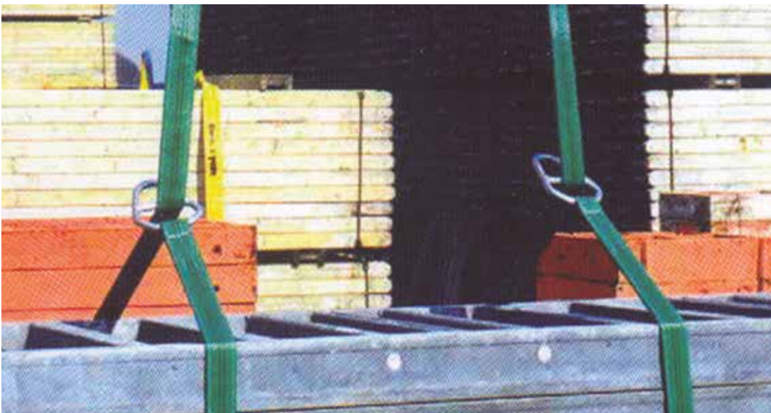
Bild 1-13: Sichere Auflage durch Beschlagteil
