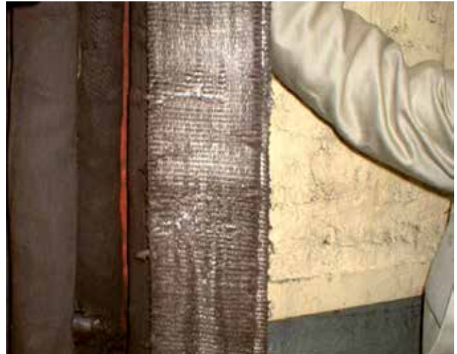
Bild 3-2: Prüfung durch einen Sachkundigen, Beispiel 2
