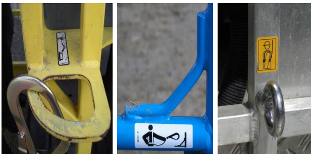
Bild 3: Verschiedene Anschlagpunkte für PSA gegen Absturz
