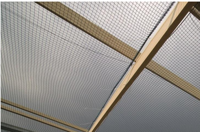
Bild 1: Straff gespannte Schutznetze an Holzleimbändern mit geringen Fallhöhen für die Monteur
