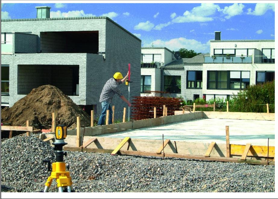
**Abbildung 6: Linienlaser beim horizontalen Ausmessen mit einem Receiver**
