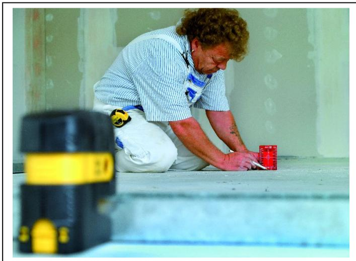
Abbildung 5: Laser zum Einmessen
