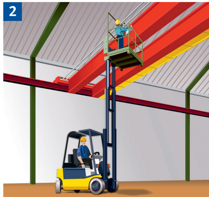
Instandhaltungsarbeiten mit Gabelstapler und Arbeitsbühne
