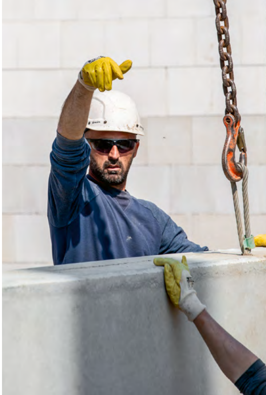
Mit Handzeichen navigiert ein Kollege die kranführende Person. Welche Handzeichen sie verwenden, legen sie vorher fest.
