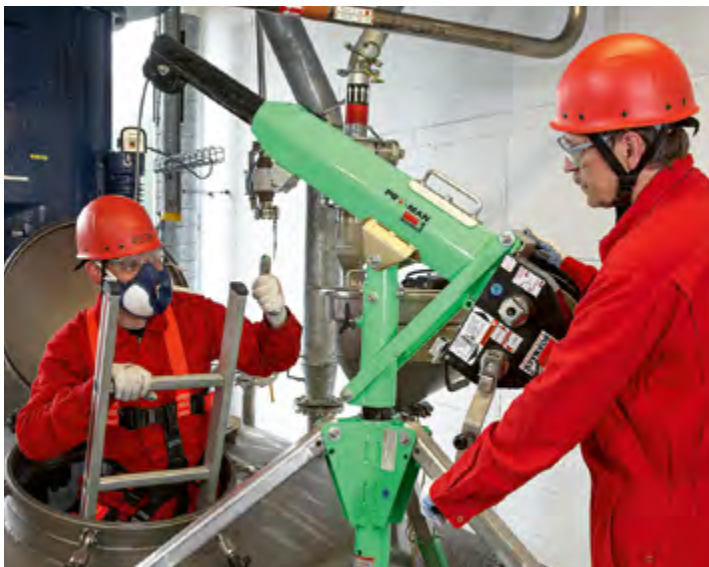
Eine Sicherung gegen Absturz ist bei Arbeiten in engen Räumen sehr wichtig.
