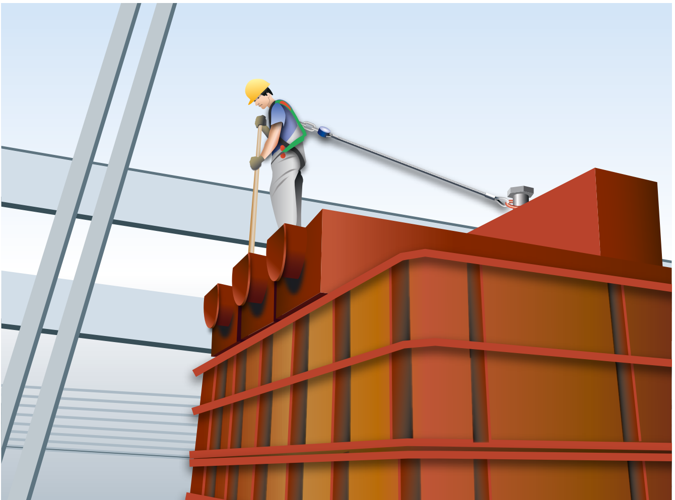
Abb. 18 Absturzsicherung auf Formkästen
