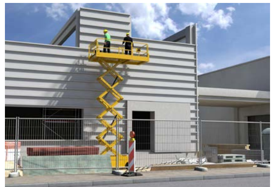
Abb. 97 Profiltafelmontage an der Fassade
