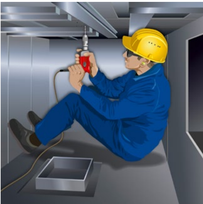
Abb. 12 Arbeiten mit elektrischer Bohrmaschine unter erhöhter elektrischer Gefährdung
