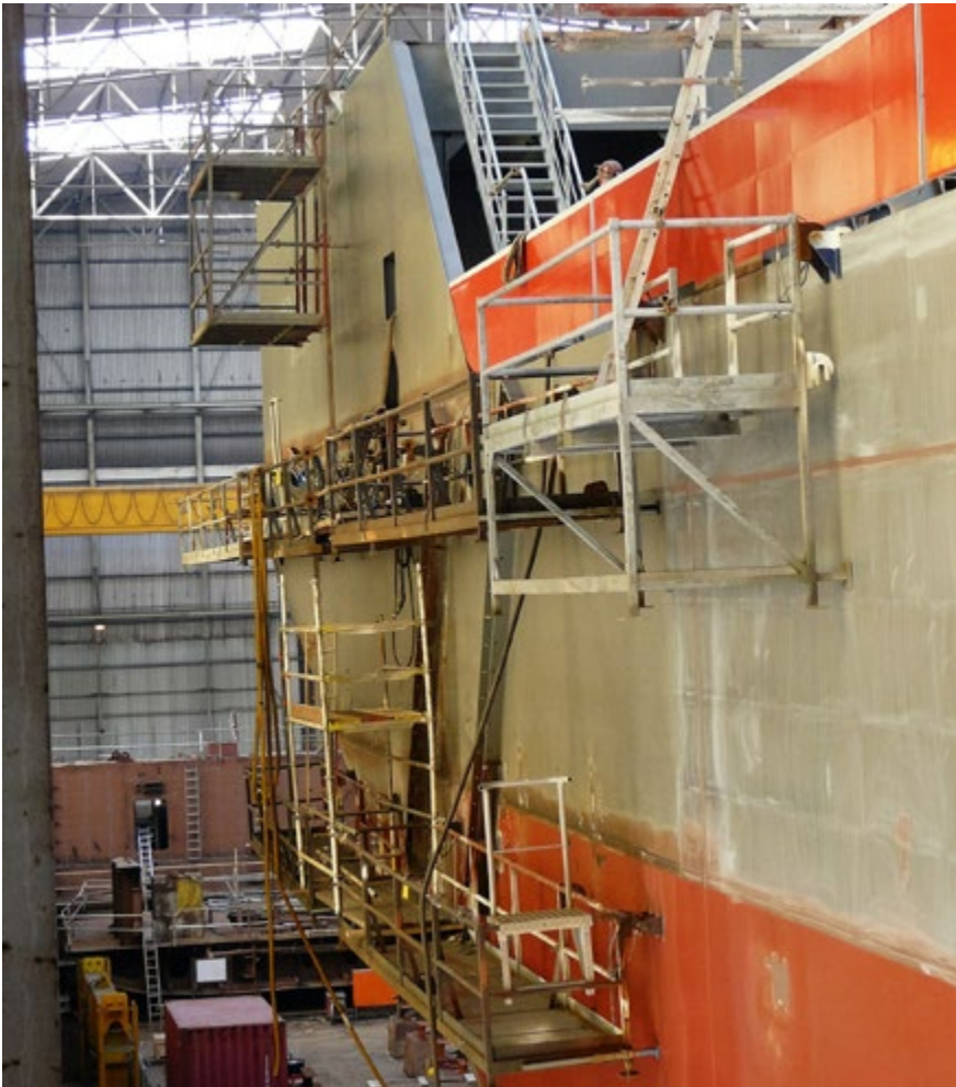
Abb. 29 Hängegerüste für Außenhautarbeiten
