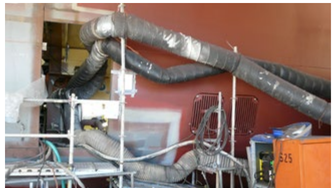
Abb. 6 Außenhautöffnung zur Medienversorgung
