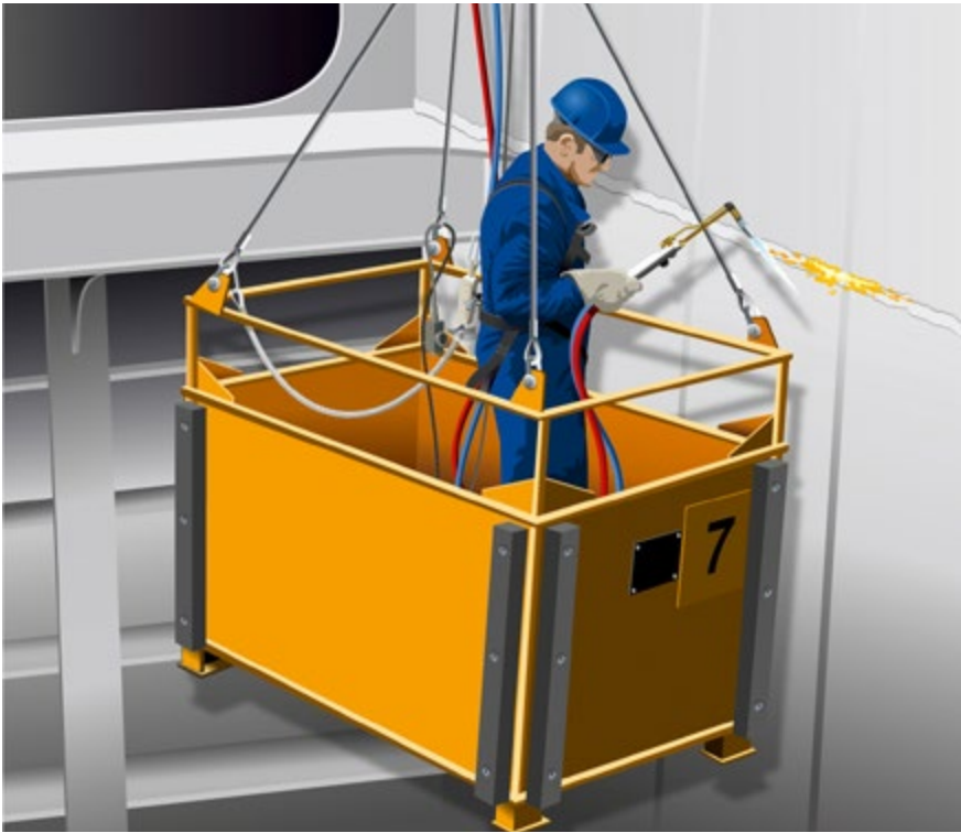
Abb. 35 Brennarbeiten im Laderaum mit Hilfe eines Arbeitskorbs
