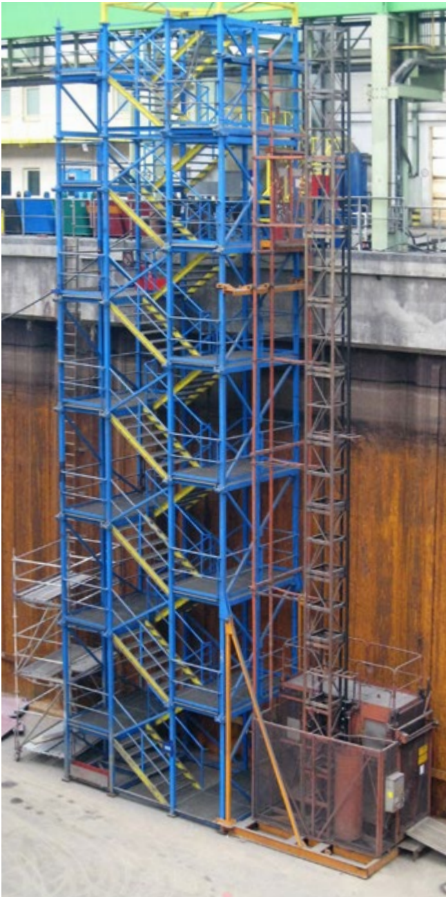
Abb. 32 Kranverlastbarer Treppenturm mit Aufzug im Dock
