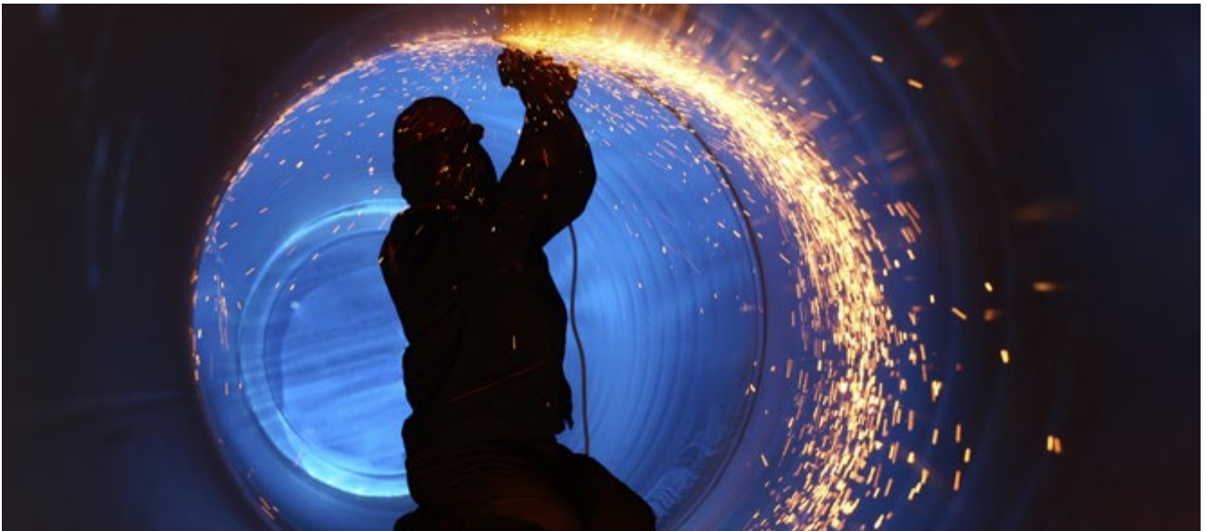
Abb. 50 Schleifarbeiten in einer Rohrleitung
