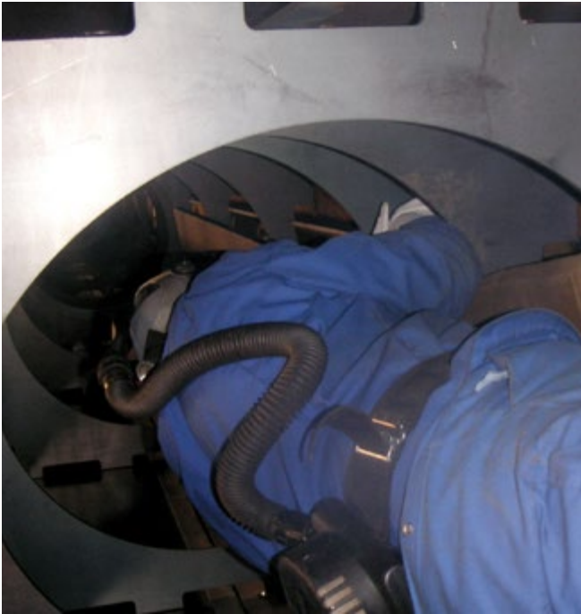
Abb. 49 Schweißen in einem engen Raum
