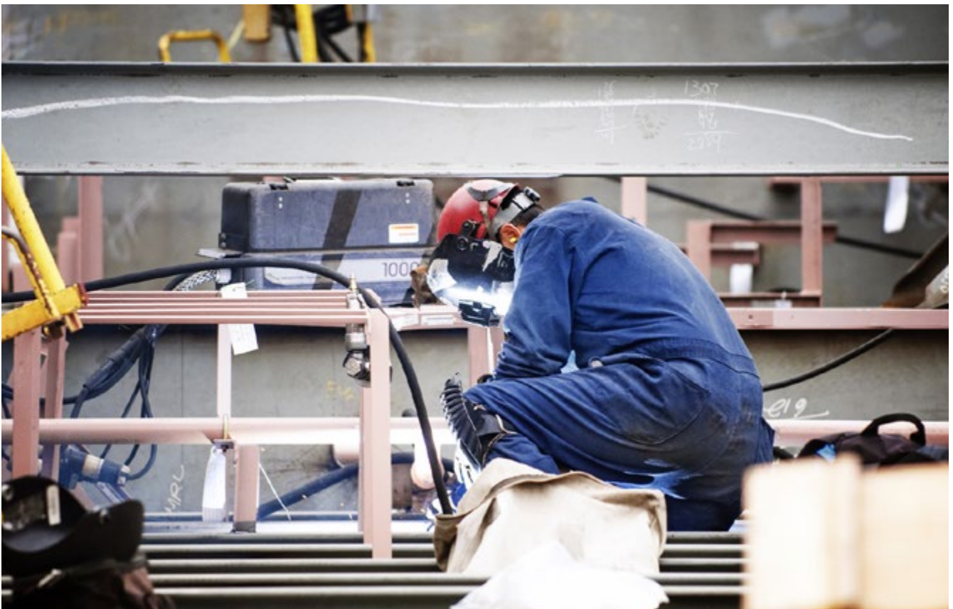
Abb. 22 Kniende Haltung bei Schweißarbeiten
