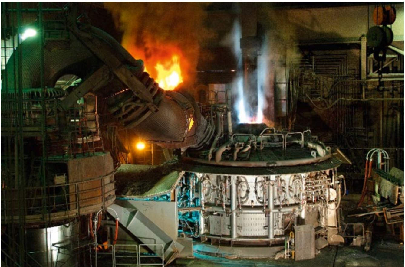
Bild 2 Gleichstrom-Elektrolichtbogenofen; deutlich sind die Kühlelemente in der Ofenwand zu erkennen
