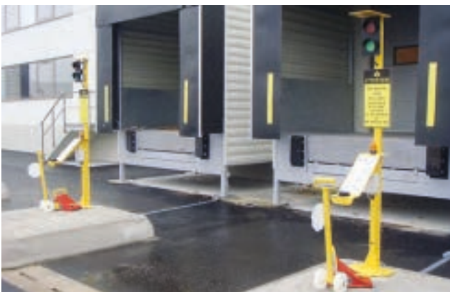
Abb. 2-14 Elektronischer Unterlegkeil mit Ampelsteuerung
