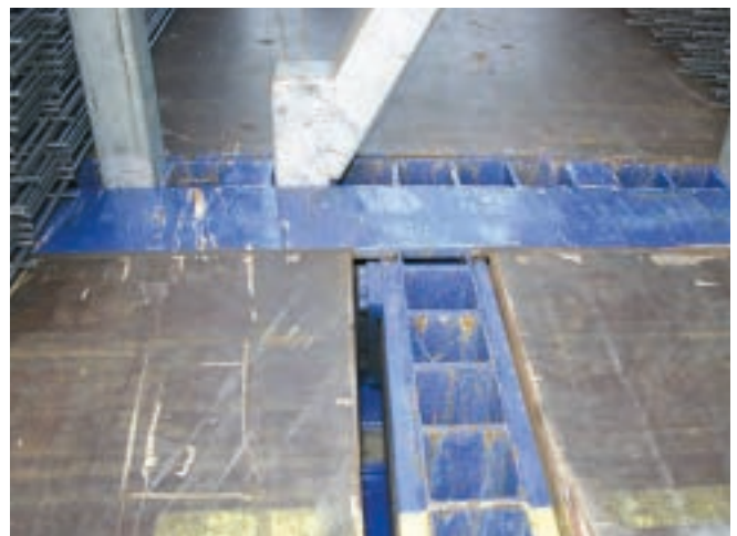
Abb. 6-59 Steckungen können in Rungenaufnahmen eingesetzt werden.
