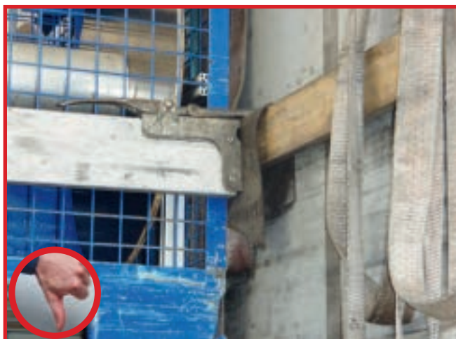
Abb. 10-57 Kann nur wenig Kraft aufnehmen: Klemmbrett
