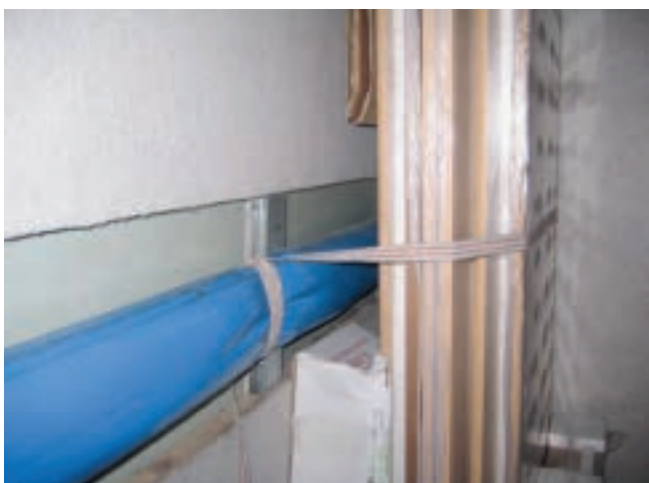
Abb. 10-50 Durch Umreifen gut gesichert: kleinere Partien
