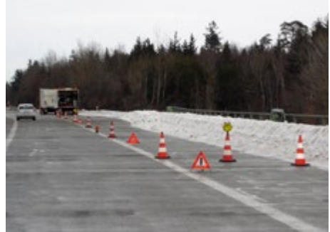
Abb. 13 Absicherung einer Einsatzstelle
