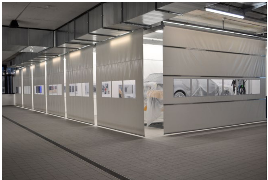
Abb. 4 Vorbereitungsplatz mit geschlossenen Abtrennungen
