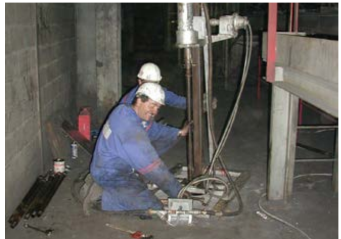
Abb. 8.3 Im Dach zum Speicherraum angesetzte Bohreinrichtung
