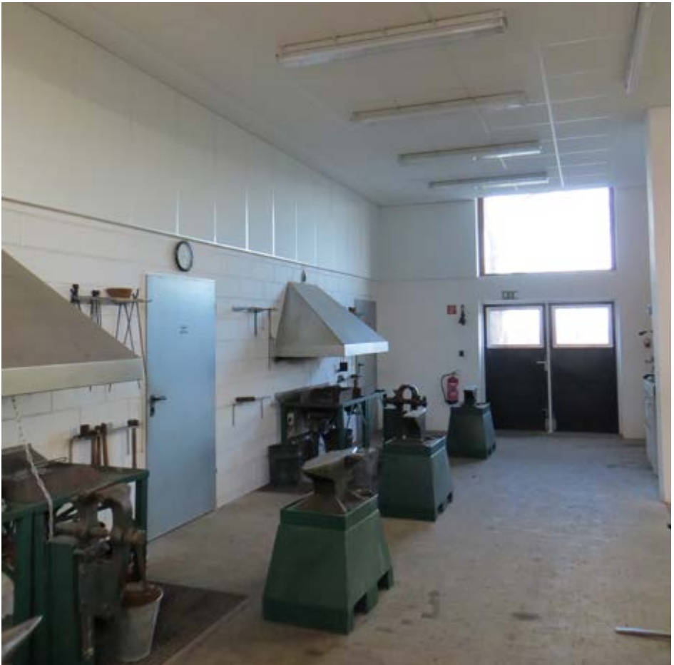
Abb. 3-3 Lärmgeminderte Decke in einer Schmiedewerkstatt
