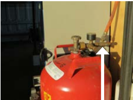
Abb. 6-3 Schlauchbruchsicherung
