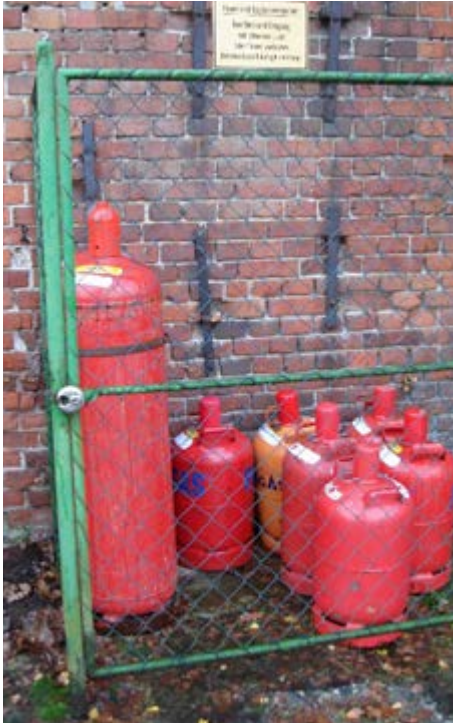
Abb. 8-2 Lagerung gefüllter Druckgasbehälter im Freien
