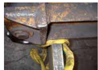
Bild 1-9: Beschädigung einer Rundschlinge durch darauf abgesetzte Traverse
