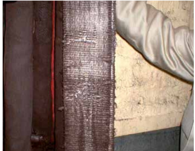
Bild 3-2: Prüfung durch einen Sachkundigen, Beispiel 2
