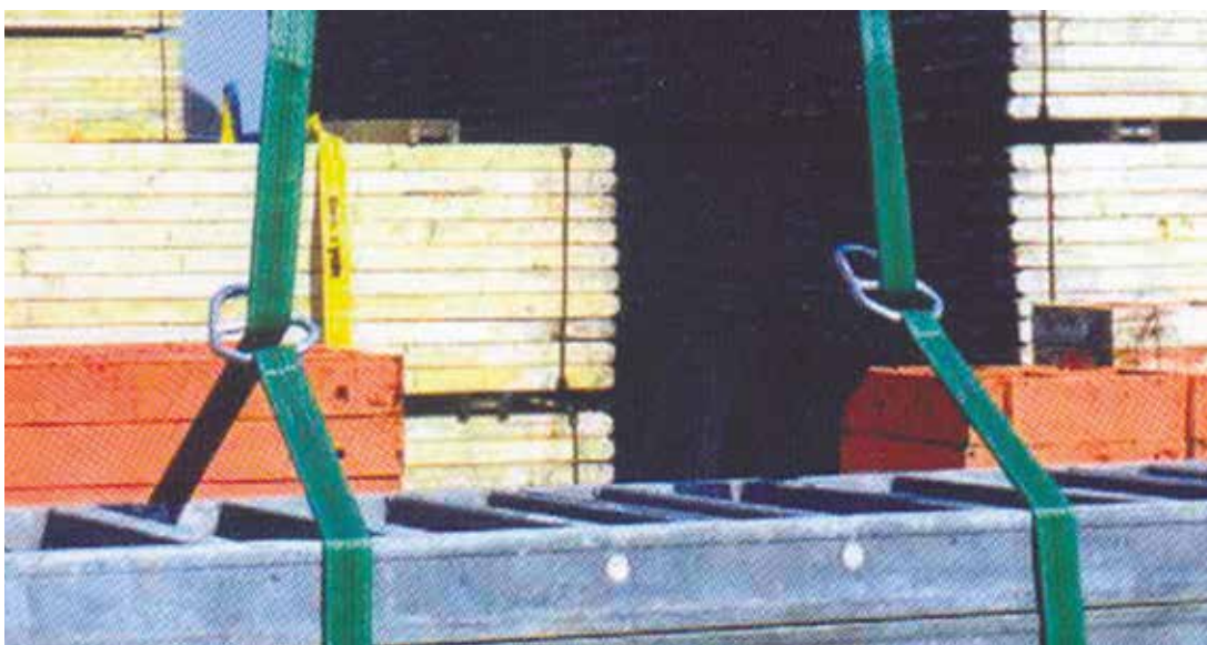
Bild 1-13: Sichere Auflage durch Beschlagteil
