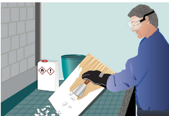
Abb. 12.4 Mitarbeiter entfernt die durch Abbeizer angelöste Farbschicht mit einem Spachtel
