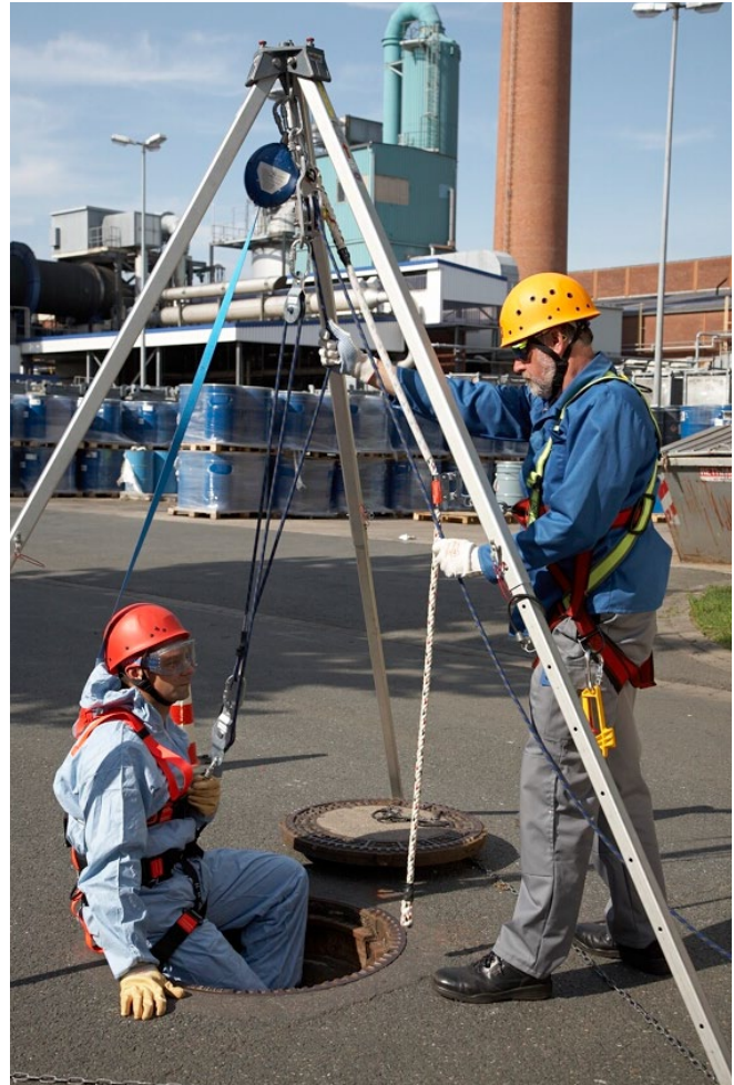
Abb. 9-4 Einstieg in einen Kanal mit erforderlicher Schutzausrüstung
