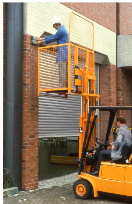
Abb. 4-5 Flurförderzeug mit Arbeitskorb
