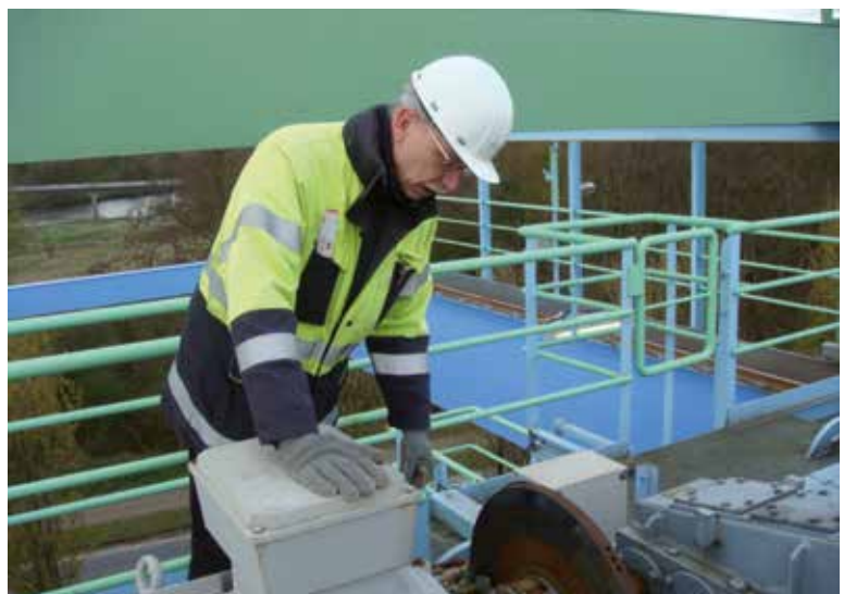
Bild 4-6: Der Kranführer nimmt die Bremse in Augenschein
