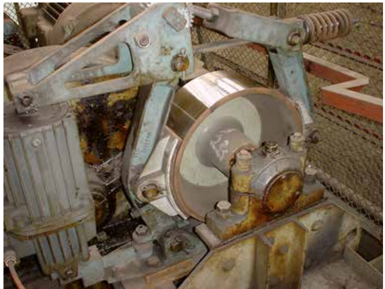
Bild 4-4: Inaugenscheinnahme einer Trommelbremse
