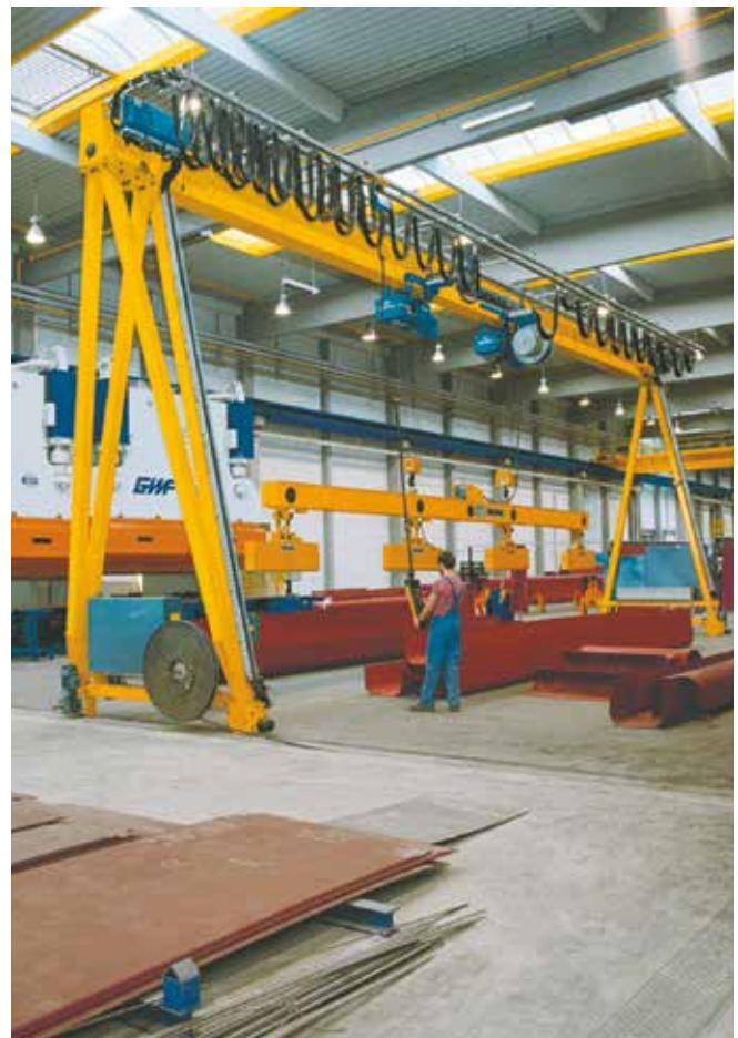
Bild 3-2: Der Kranführer steuert den Kran mittels der an der Kranbrücke hängenden Steuertafel
