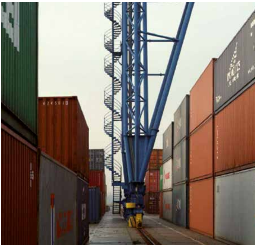
Bild 4-9: Lagerung von Container in ausreichendem Abstand zu den Portalstützen entlang der Fahrbahn eines Portalkranes
