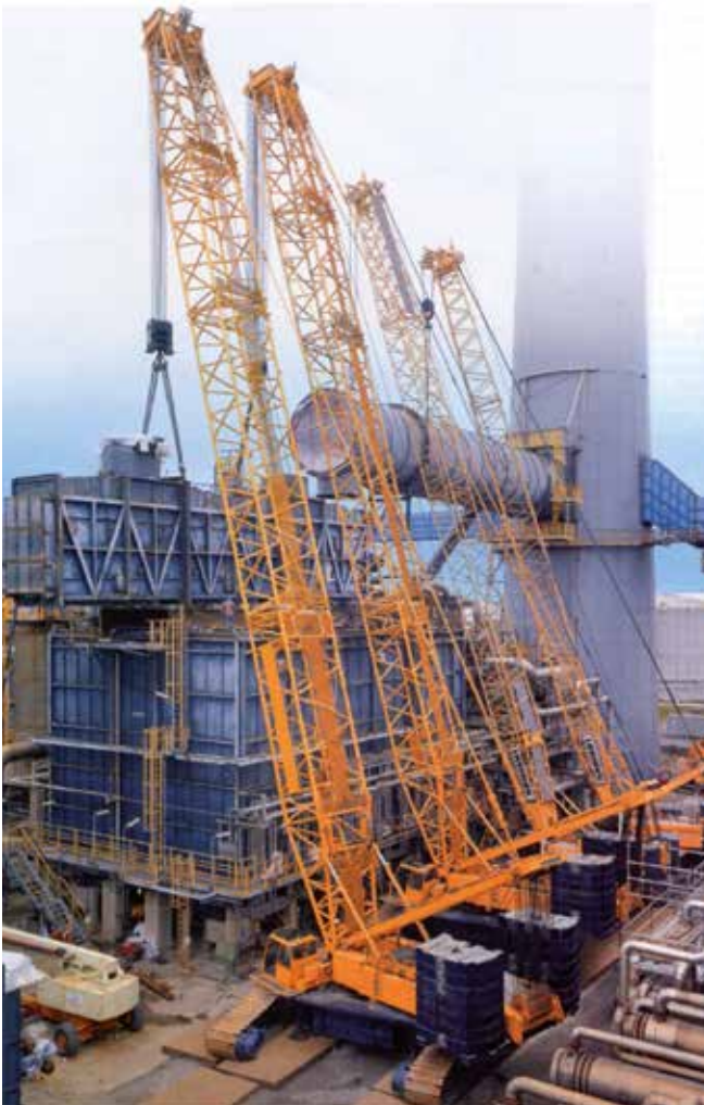
Bild 6-1: Zusammenarbeit von vier Kranen
