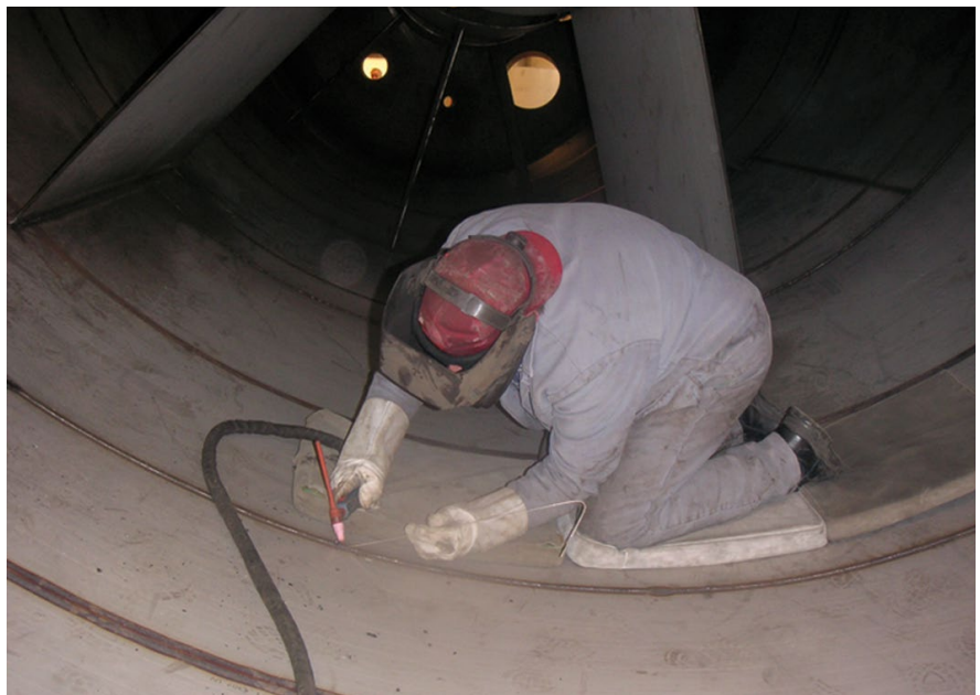
Abb. 5-4 Geschützt durch isolierende Unterlage
