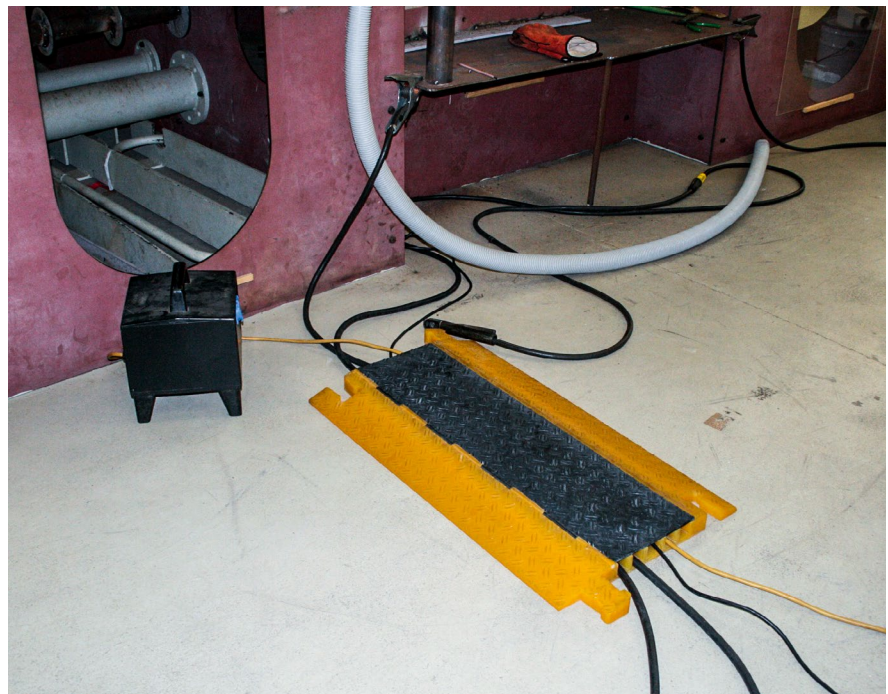
Abb. 3-4 Sicherung der Schweißleitung gegen Beschädigung beim Überfahren.
