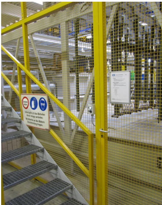
Abb. 2.1 Abgesicherter Zugang zum Galvanikbereich (Galvanoautomat)
