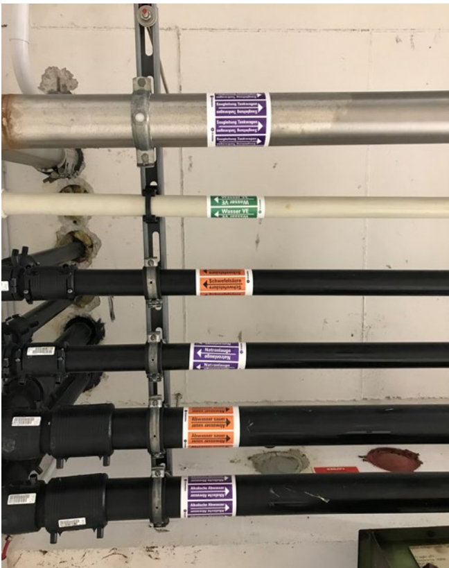
Abb. 2.5 Kennzeichnung von Rohrleitungen nach TRGS 201
