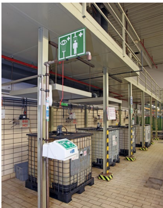
Abb. 1.4: Augendusche und Körpernotdusche im Lagerbereich für Gefahrstoffe
