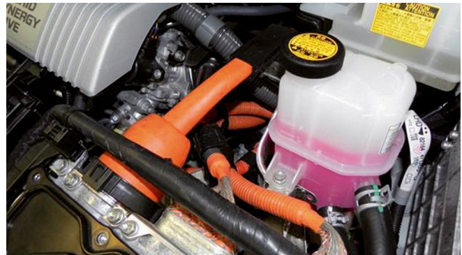
Abb. 8-1 Orange gekennzeichnete HV-Kabel
