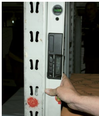
Abb. 10 Messung der Schiefstellung mit digitaler Wasserwaage
