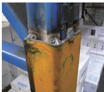
Abb. 11 Unfachmännisch geschweißte Stütze
