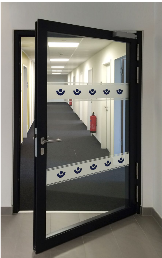
Abb.9 Brandschutztür mit Verglasung
