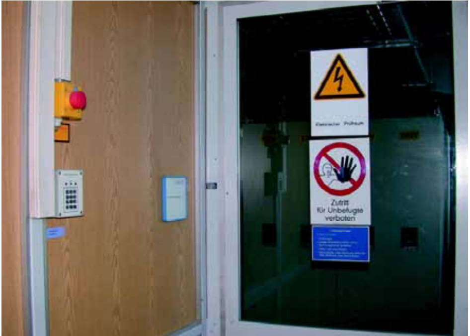
Bild 9: Zugang zu einem Dauerversuchsraum, Kennzeichnung der Zugangstüre, Zugang mittels codierter Türverriegelung nur für befugtes Personal
