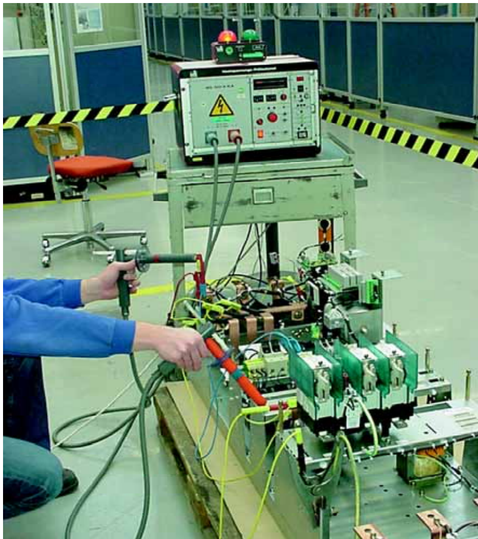
Bild 6: Prüfarbeiten unter Verwendung von Sicherheitsprüfspitzen
