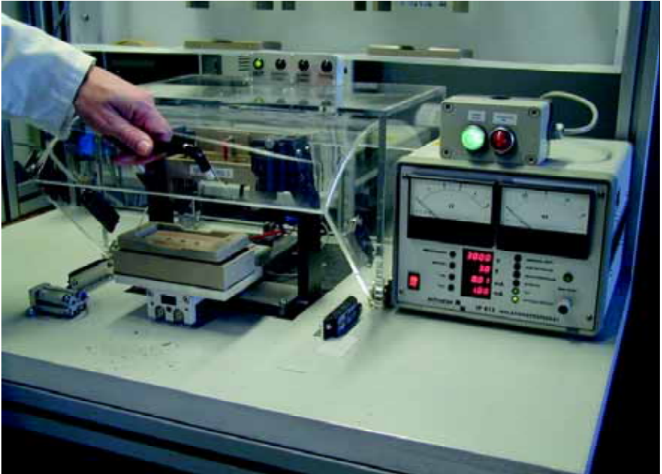
Bild 3: Prüfplatz mit zwangsläufigem Berührungsschutz, vollständiger Berührungsschutz durch Gehäuse mit beweglicher Verdeckung, elektromechanische Verriegelung mit Stellungsüberwachung (hier: Endschalter mit Personenschutzfunktion)
