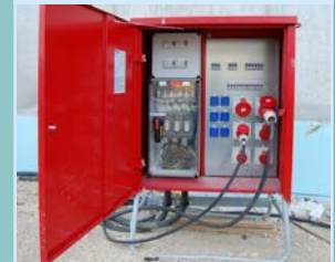
Baustromverteilerschrank
