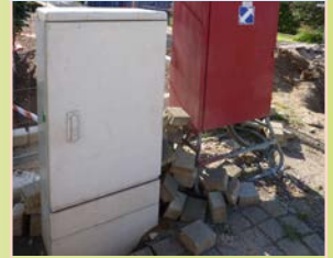
Kabelverteilerschrank
