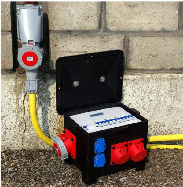
Abb. 17 Mobiler Verteiler mit RCD, Leitungsschutzschaltern und mehreren Steckdosen
