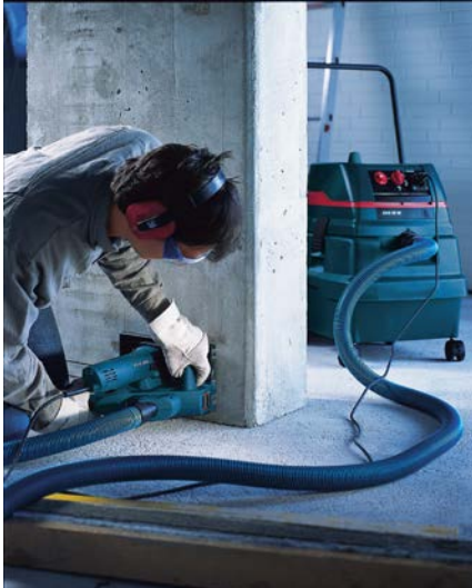
Abb. 22 Mauernutfräse mit Staubabsaugung
