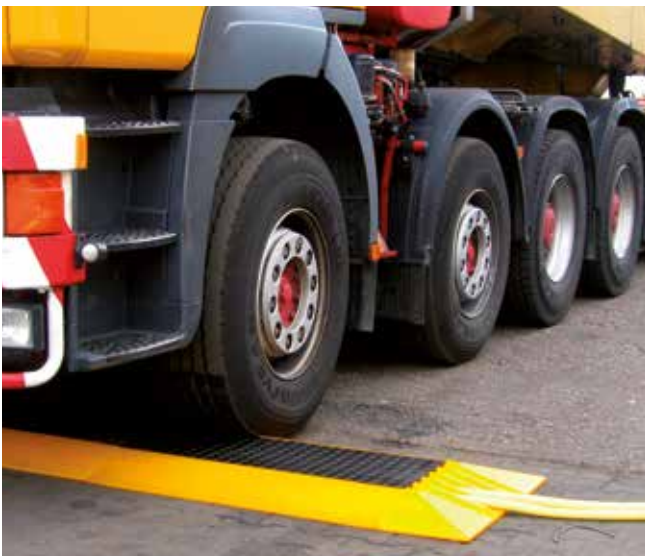
Bild 5-28: Schutz von Baustellenkabeln auf Verkehrswegen
