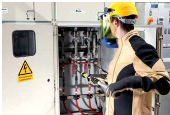
Bild 5-16: Feststellen der Spannungsfreiheit in einem Schaltfeld
