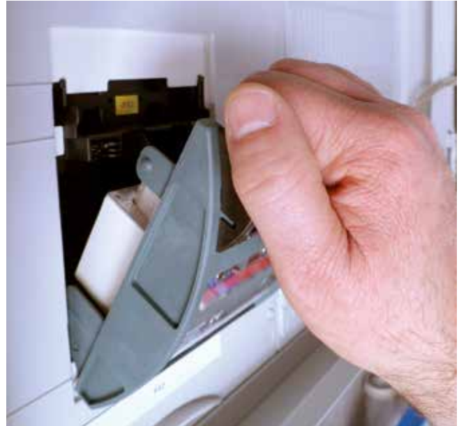
Bild 5-34: NH-Sicherungslasttrennschalter
