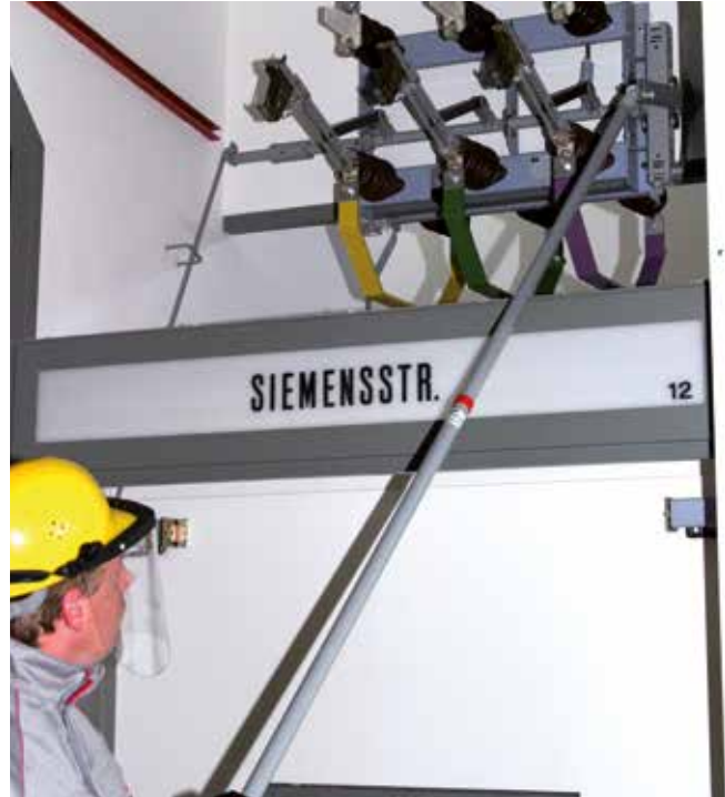
Bild 5-10: Elektrofachkraft beim Öffnen eines Hochspannungstrenners
