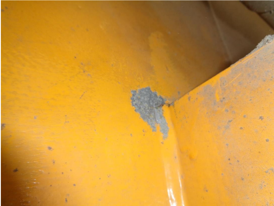
Abbildung 6 Entfernen der Beschichtung
