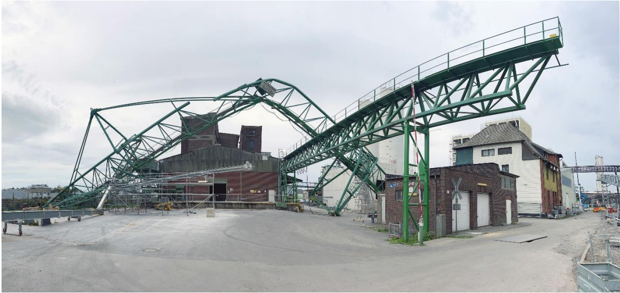
Abbildung 1 Einsturz eines Krans, verursacht durch einen unentdeckten Riss im Obergurtrohr
