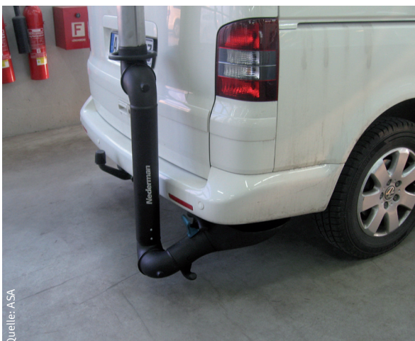
Bild links: Berührungslose Absaugeinrichtung für alle Fahrzeugtypen
