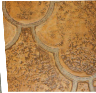
Asbesthaltige Fußbodenbeläge
