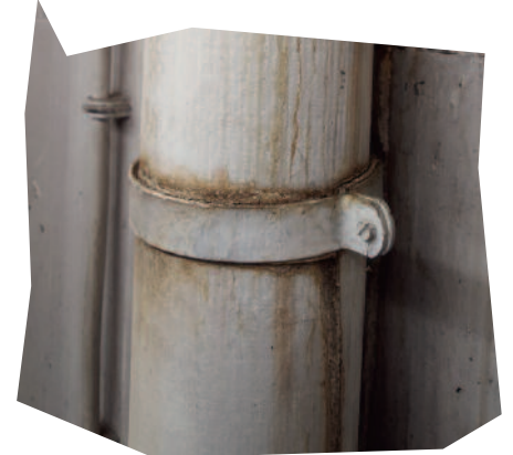
Asbestzement-Entwässerungsleitung
