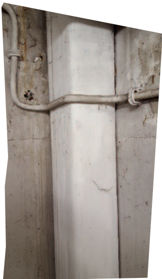
Asbestzement-Lüftungskanäle
